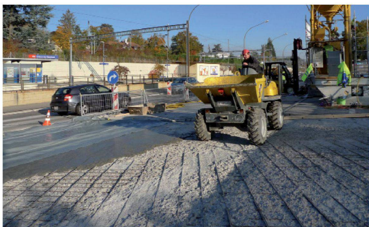
Fig. 6 : Vue d'ensemble des travaux d'application de BFUP sur la dalle de roulement du P.I. du Creux de Genthod (1 ère étape)
