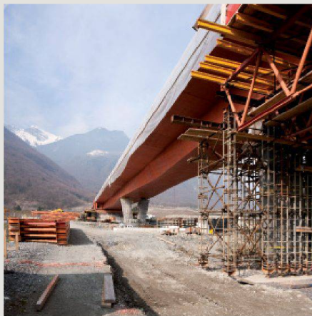
Le viaduc sur le Rhône réalisé dans le cadre de la H144 (Photo Yves André)
