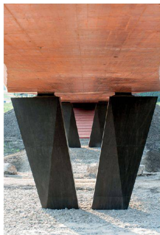
8 Ligne rouge sur le Rhône < Sous le « Pont rouge » (Sauf mention, toutes les photos illustrant cet article ont été fournies par www.ateliermamco.com )
