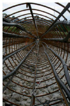
Equipement d'un pieu énergétique (Photo LMS-EPFL)
