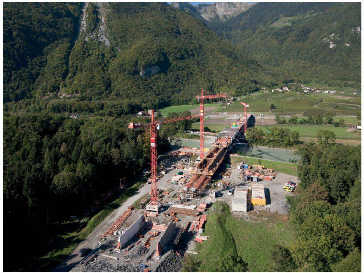
Fig. 4 : Dispositif pour la réalisation des pieux de diamètre 1500 mm (Photo Jean Jeker)
