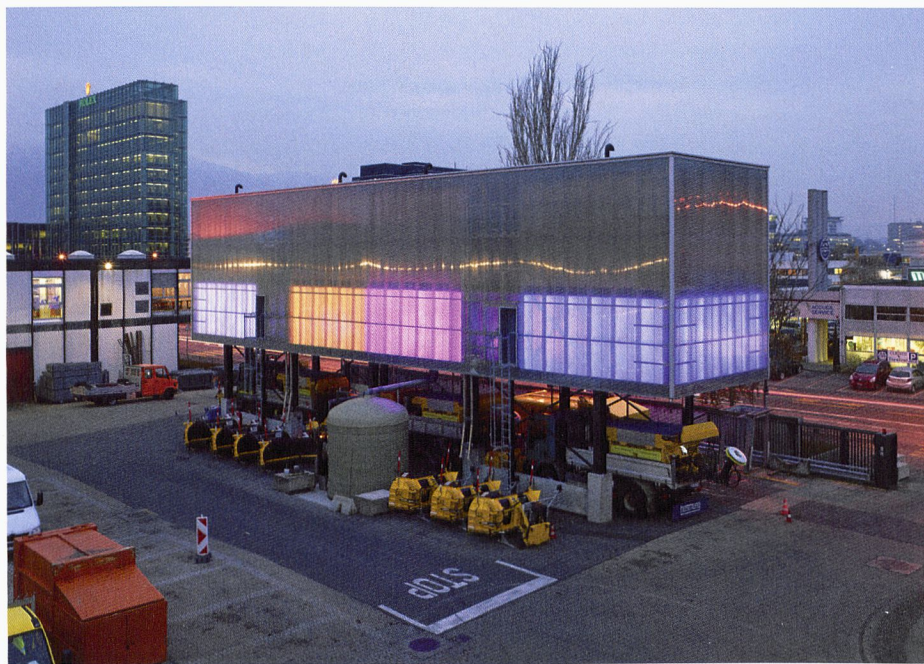
Sans titre, Pieter Vermeersch, 2013, silos à sel sur le site de la voirie de la Ville de Genève. Commande du FMAC (Photo Serge Fruehauf)
