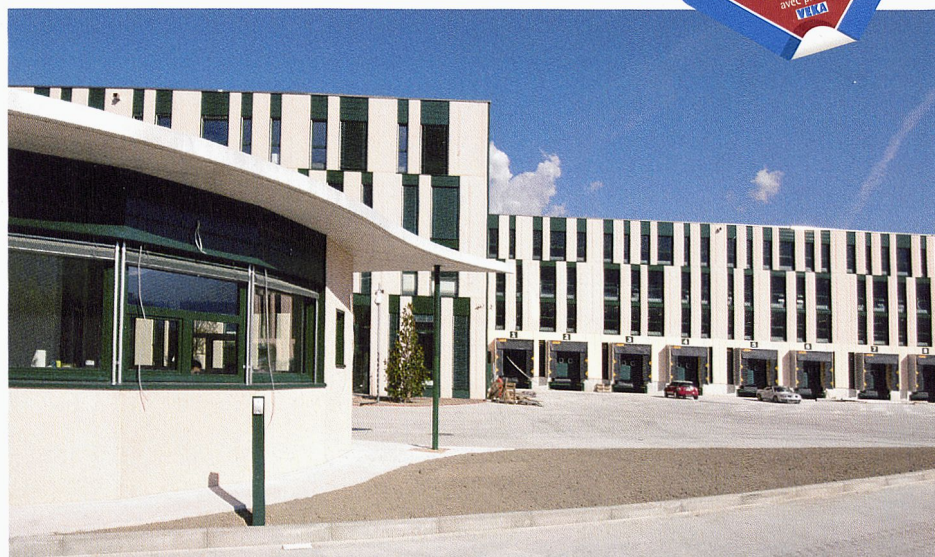
Le nouveau centre logistique Gucci mise sur SOFTLINE 82
