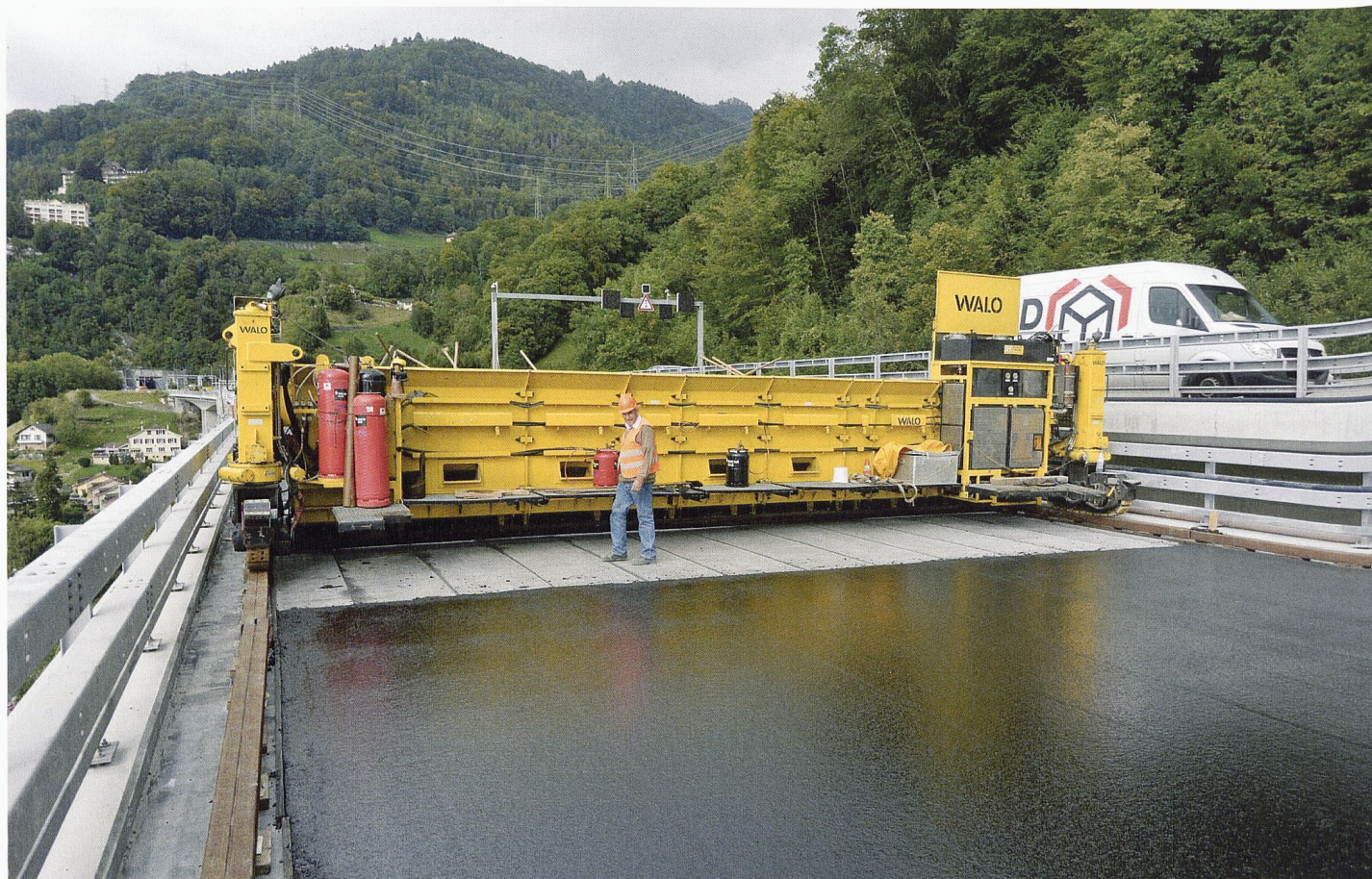
8 Pose de l'étanchéité et du MA sur le BFUP (Sauf mention, tous les documents illustrant cet article ont été fournis par les auteurs.)
