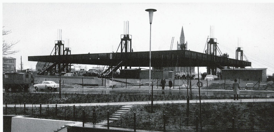
David Chipperfield: Neue Nationalgalerie, relèvement du toit, 05.04.1967. (Photo Archiv Neue Nationalgalerie, Nationalgalerie, Staatliche Museen zu Berlin)
