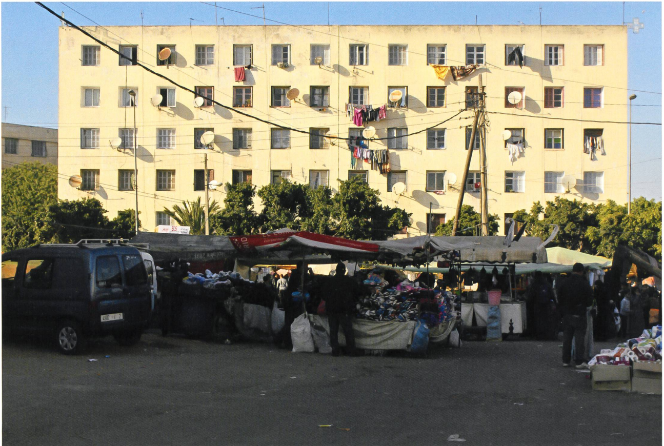
Un des nombreux immeubles modernistes du plan d'urbanisme colonial français pour Hay Mohammadi à Casablanca (photo Léopold Lambert, 2016)
