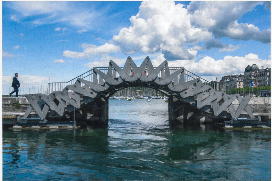
La passerelle mobile du ponton du Jet d'eau de Genève. (Photo Adrien Barakat)
