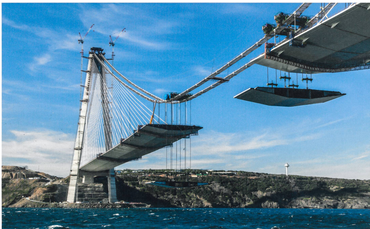
Mise en œuvre du tablier du pont routier et ferroviaire sur le Bosphore conçu par Jean-François Klein (T-ingénierie intl.) et Michel Virlogeux. (Photo T-ingénierie intl.)
