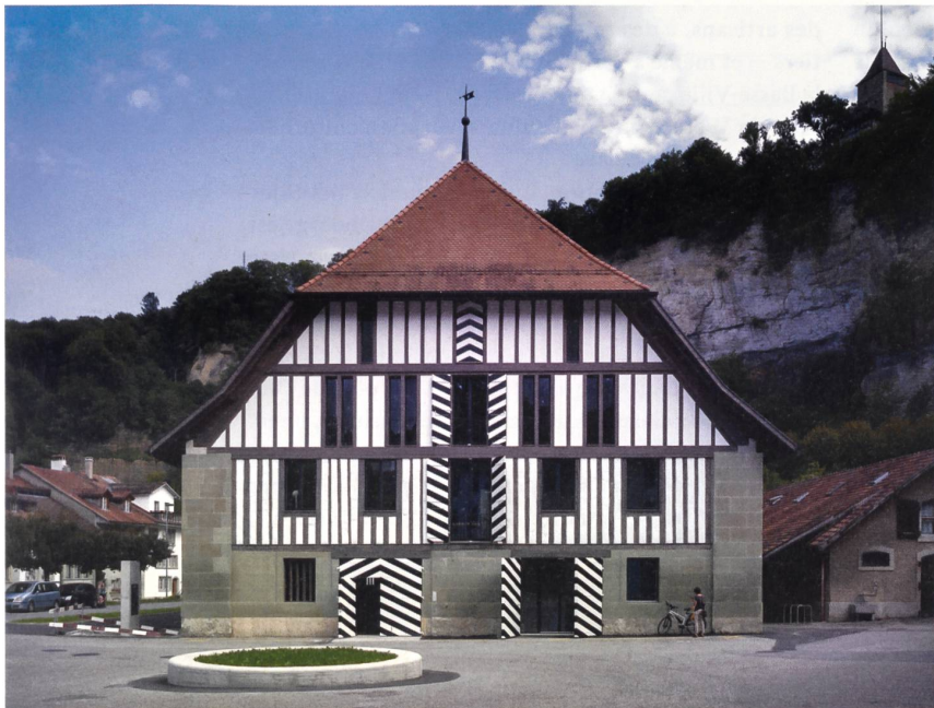
4 La trame des colombages, partiellement détruits par l'incendie de 1998, a été reconstituée pour composer la nouvelle façade. A gauche, l'entrée mène à l'espace extérieur «Tara». (© Marco Bakker)
