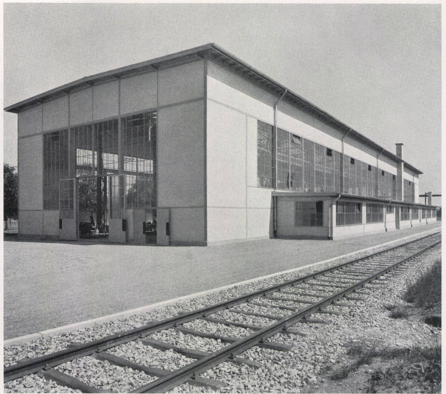
Ansicht von der Bahnseite / Vue prise du côté de la voie ferrée / View of railway front
