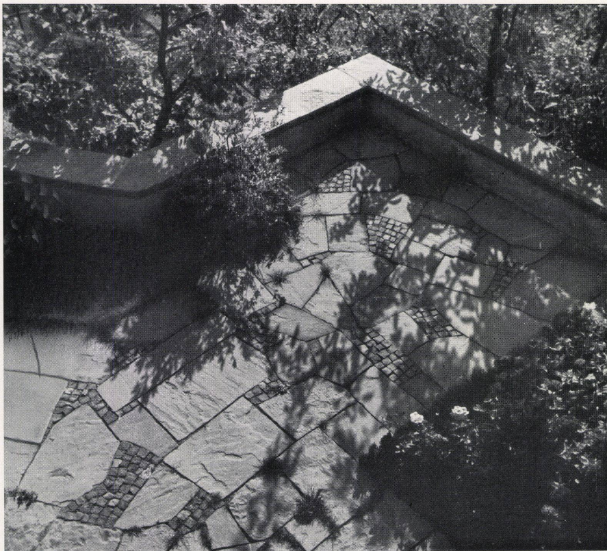
2 Der über einen Garageplatz führende Zugang ist durch Platten betont. Die dekorative Wirkung wird durch längs und quer gelegte, verschieden getönte Platten erhöht.
