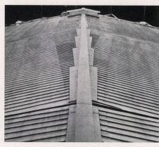
Neues Kurtheater Baden, Explosionsklappen und Oblicht bei Kinokabine, sauberer Anschluß an Furaldach und Firstentlüftung.
