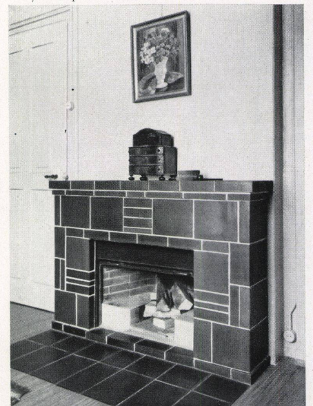
Einfaches Klinkercheminée mit handgeschmiedeter Jalousie / Cheminée revêtu de planelles Klinker / Fire-place in Klinker-tiles.
