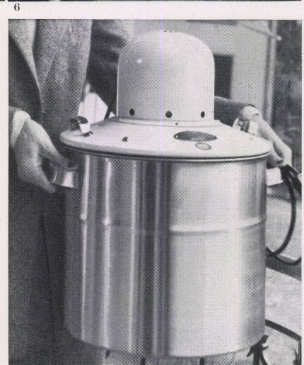
3 Fahrbare elektrische Waschmaschine « Easy ». Gewicht: 86 kg. – Maße: 90 × 65 × 100 cm. – Motor: ¼ PS 220 Volt. – Fassungsvermögen: 3,5 kg Trockenwäsche. Firma Großenbacher & Co., Zürich
