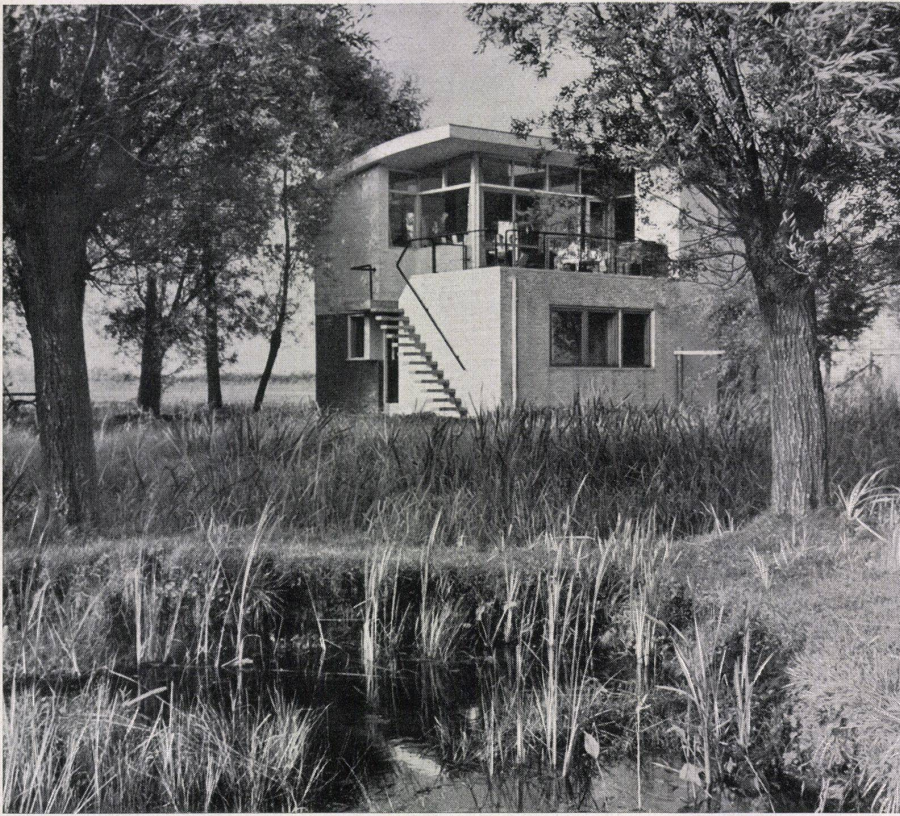
Gesamtansicht Vue générale General view
