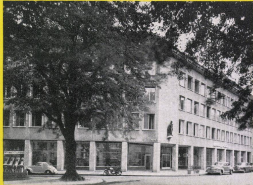
Schweiz: Büro- und Geschäftshaus, Zürich
