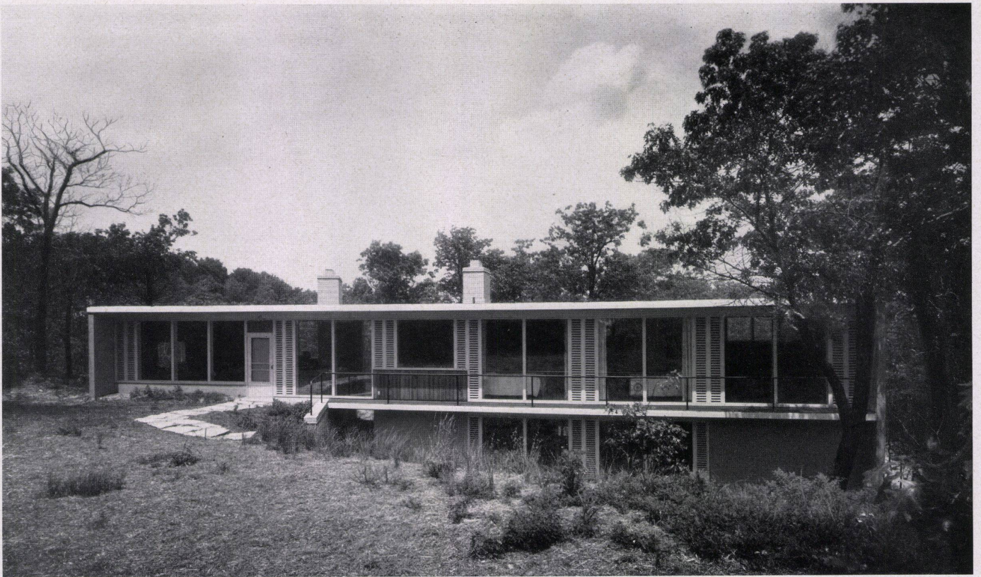
Südfassade mit Gartenabgang aus Wohnraum. Façade sud; ouverture du living-room sur le jardin. South façade with french window from living-room.
