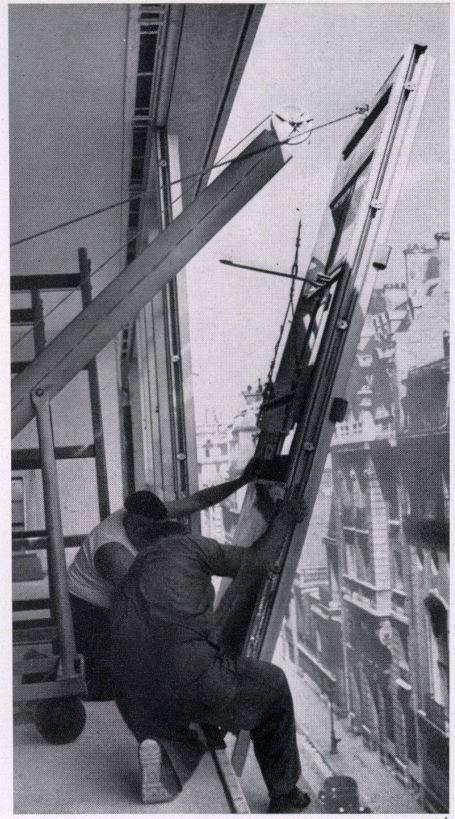
1 Aufnahme im Rohbau. Das zweitoberste Geschoß ist »verglast«. Vue du gros-œuvre. L'avant-dernier étage est «vitré». The raw structure. The second storey from the top is glassed-in.
