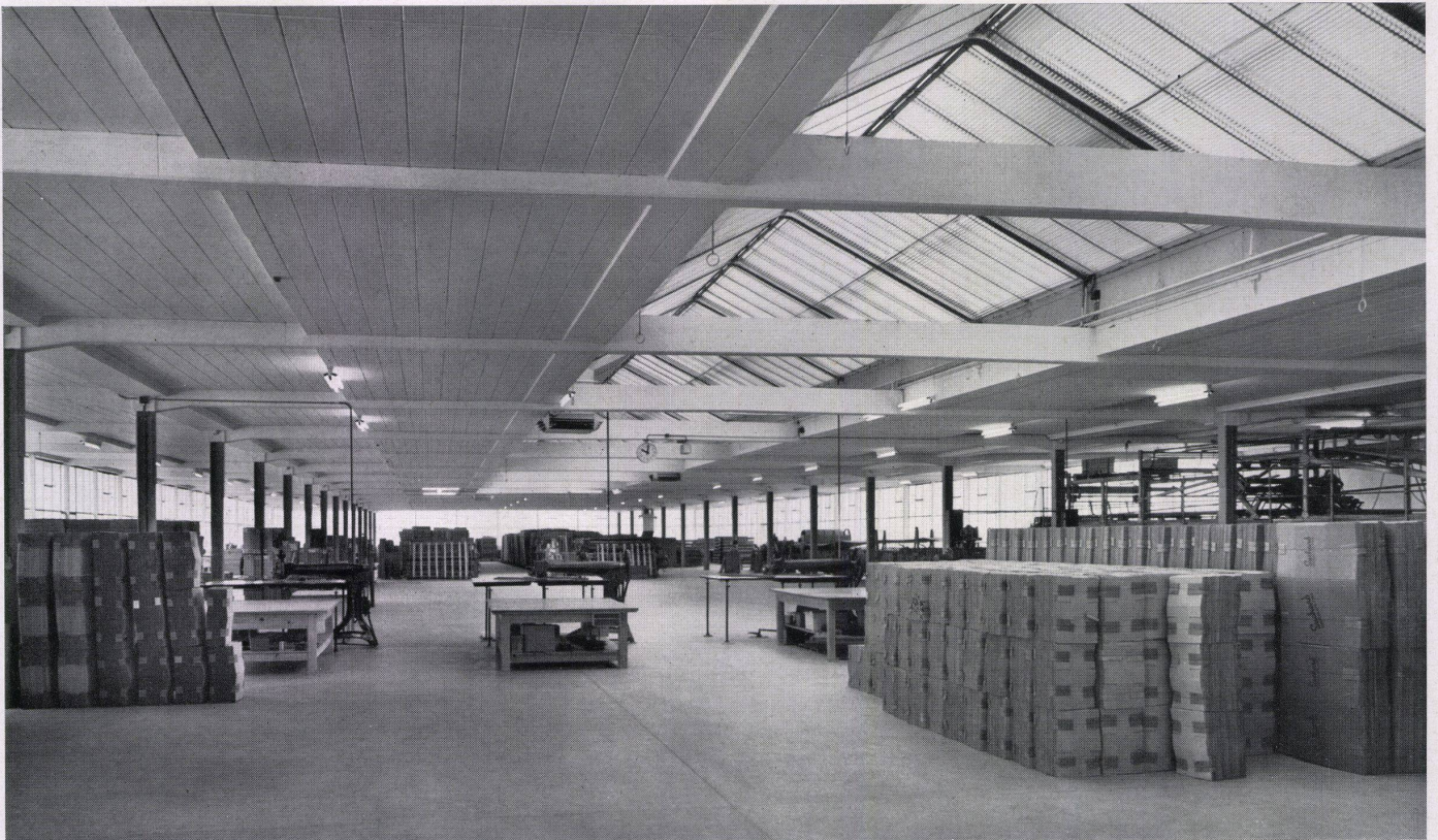
Fabrikationshalle im Erdgeschoß. Oberlicht mit Lamellenstoren. Salle de fabrication au rez-de-chaussée. Jour supérieur garni de stores à lamelles. Manufacturing department on ground-floor. Skylight with slot blinds.
