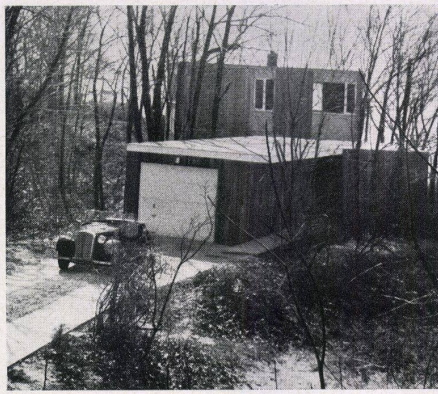
Ostansicht mit Eingang / Vue prise de l'est, côté entrée / East view with entrance.
