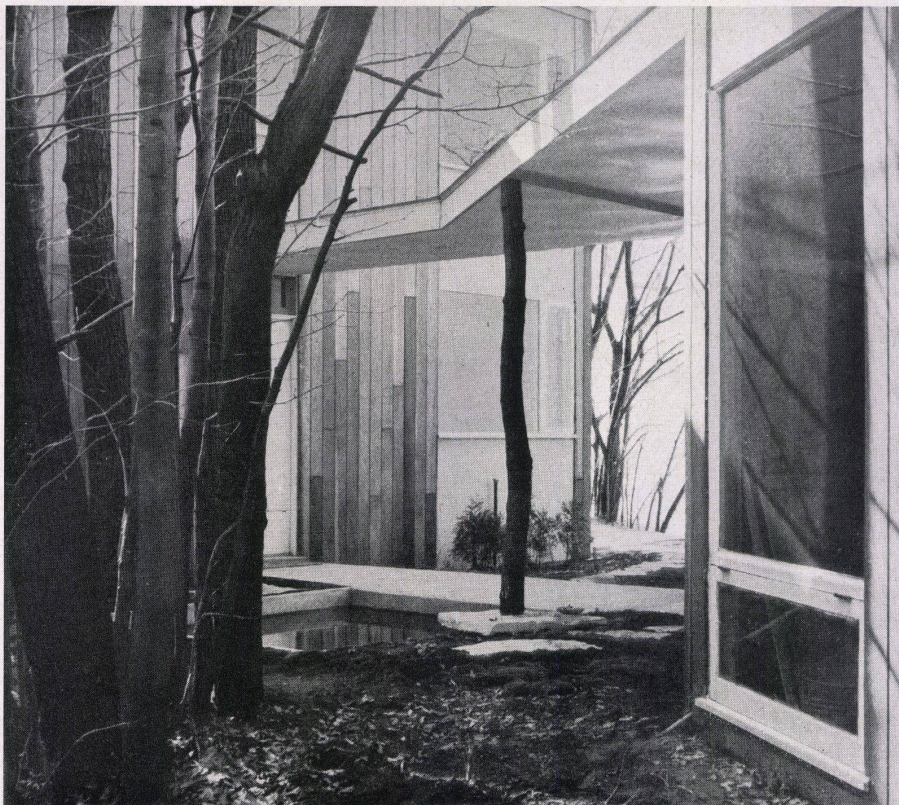
Hauseingang mit Teich und Verbindungsdach / Entrée avec étang et chemin couvert / Entrance with pool and connecting roof.
