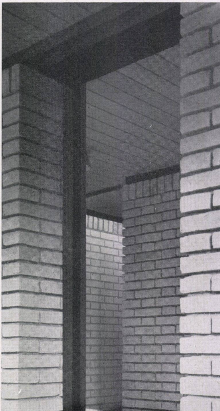
Blick von der gedeckten Terrasse durch das Badezimmerfenster in den Toilettenraum / Vue prise de la terrasse couverte par la fenêtre de la salle de bains sur les lavabos / View into lavatory from covered terrace through bathroom window.
