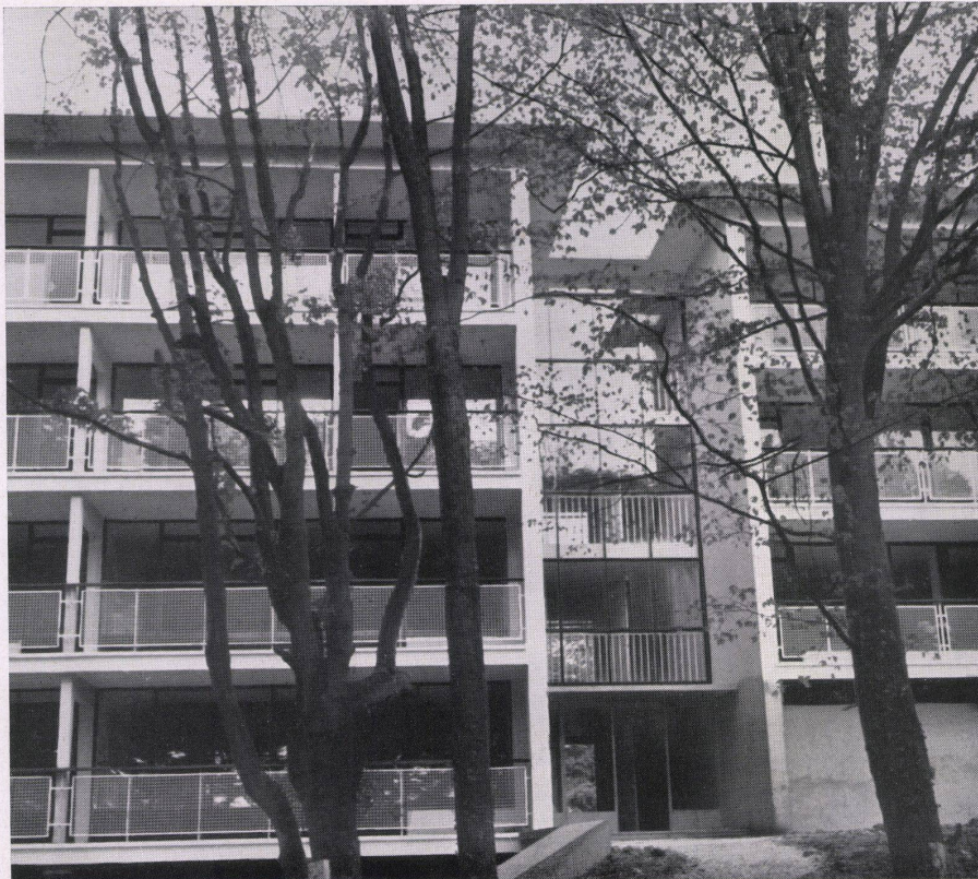
Loggien und Treppenhaus. Loggias et cage d'escalier. Loggias and staircase.
