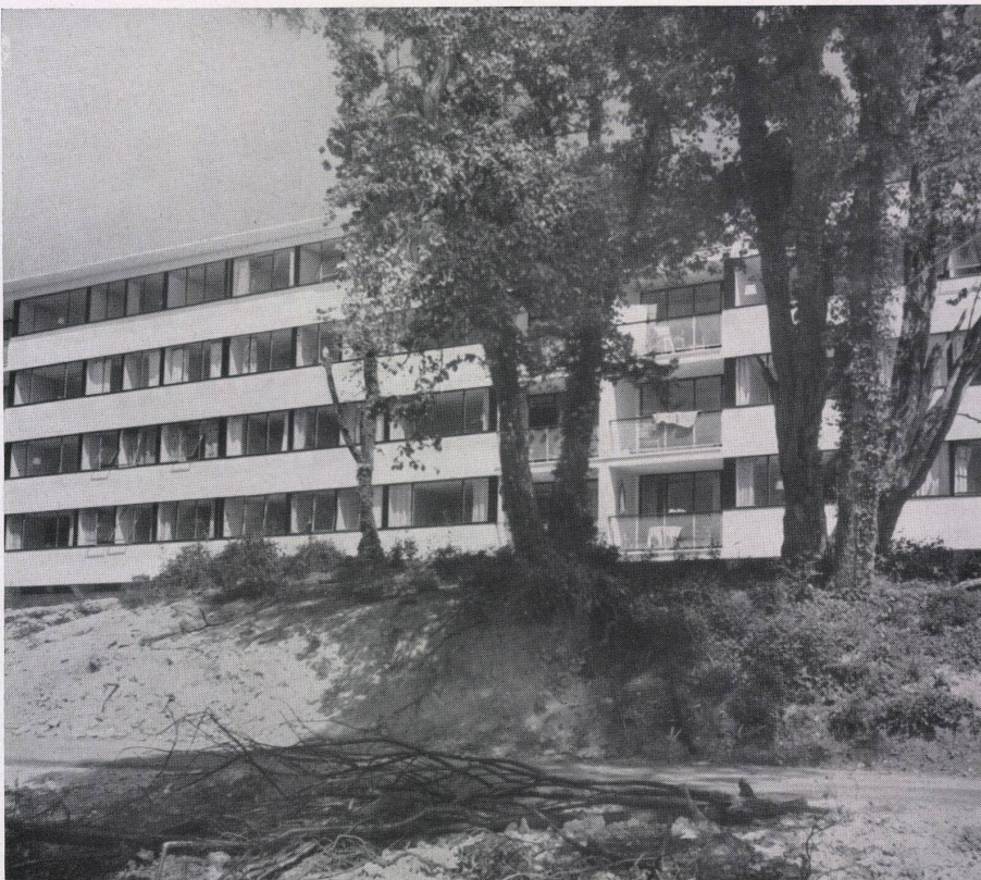
Block 2. Südfassade. Wohnungstyp I. Über dem Keller sind die Kragbalken des Erdgeschoßbodens sichtbar. Bloc 2. Façade sud. Type d'habitation I. Les traverses portant le rez-de-chaussée font saillie. Block 2. South façade. Flat type I. Above the cellar the cantilever beams of the ground-floor floor are visible.
