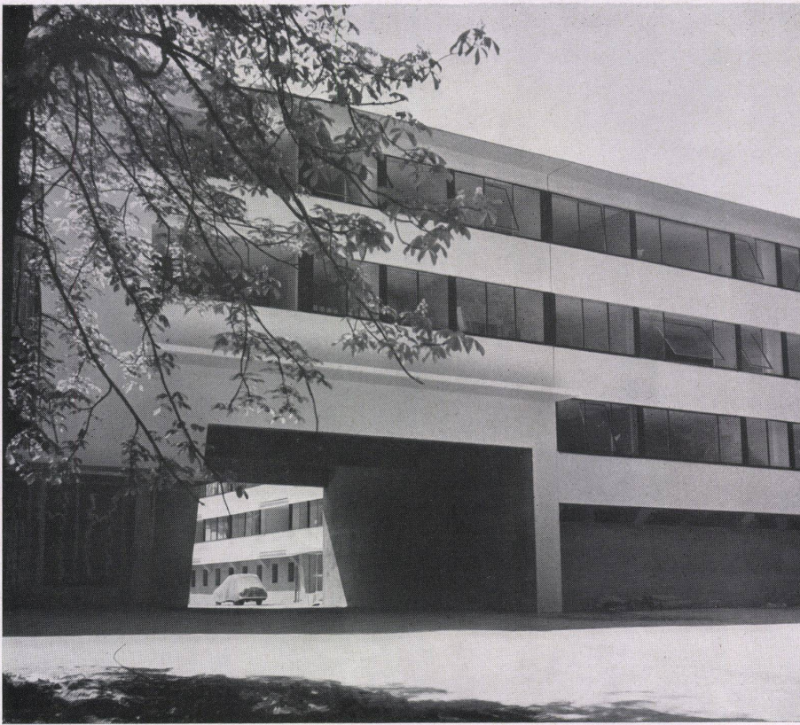
Block 4 mit Durchblick zu Block 3. Wohnungstyp I. Bloc 4 avec échappée sur le bloc 3. Type d'habitation I. Block 4 with view of Block 3. Flat type I.
