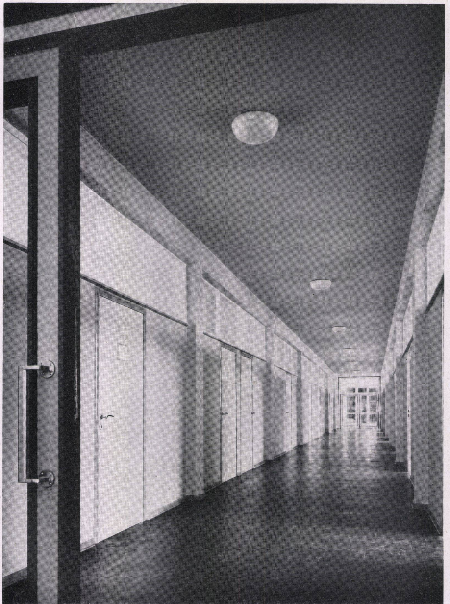
Mittelflur im Verwaltungsbau. Beiderseits Lichtband, Holztüren in Stahlzargen, Wände bis Türhöhe mit stoßfestem und abwaschbarem Anstrich, Fußboden Floorbest. Palier central du bâtiment administratif. Central landing in the administrative building.
