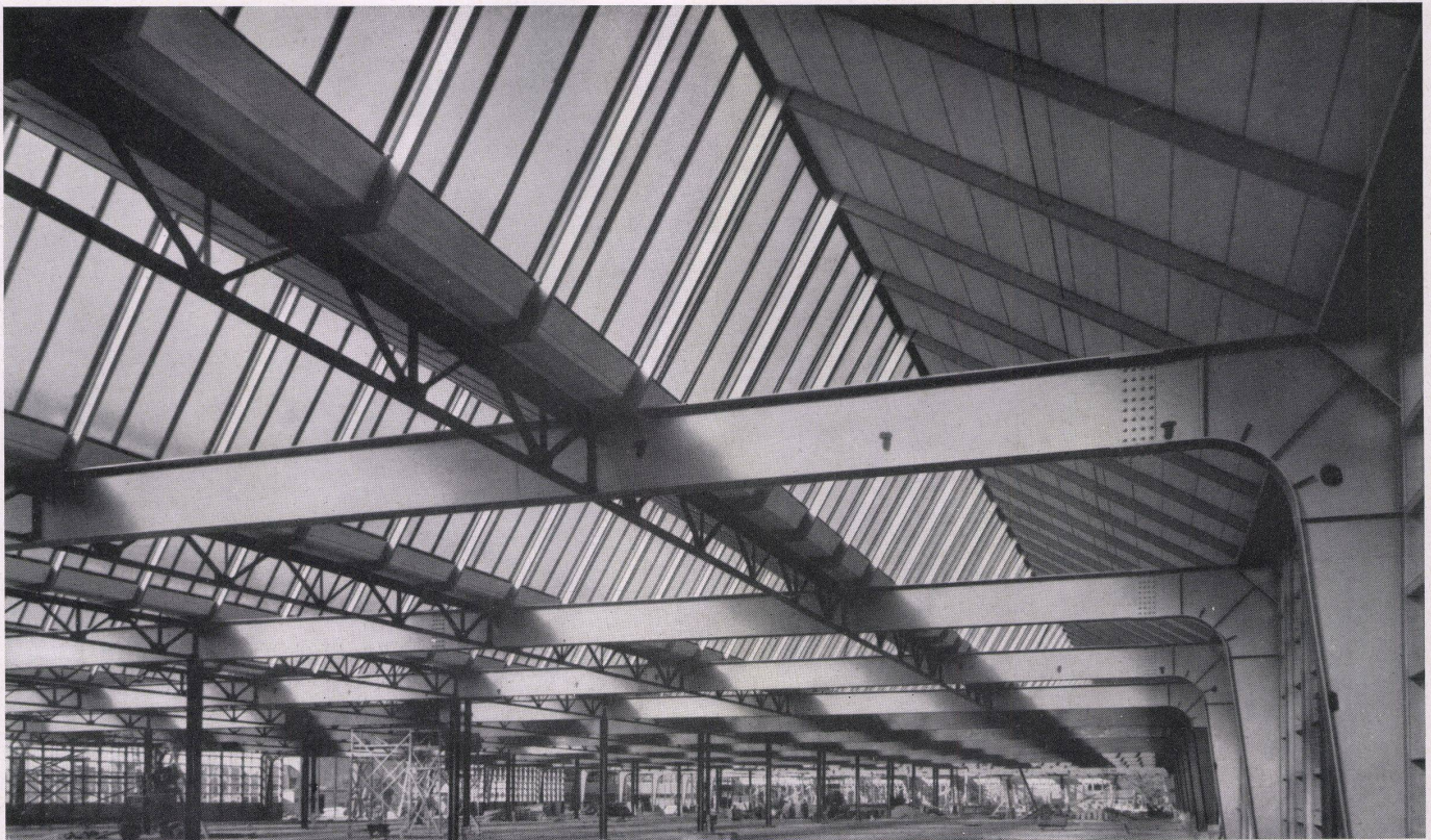
Maschinenhalle. Halle des machines. Machine shop.
