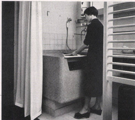
Blick in Kleinküche. Der Trog wird als Spülbecken verwendet. Neben dem Trog der Durchlauferhitzer. Vue de la cuisine. L'auge sert d'évier. Le boiler est à côté de l'auge. View into the kitchenette. The trough is used as a washing-up bowl. Near the trough, the flow heater.
