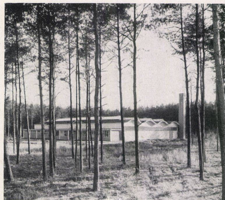
Blick durch die Waldlichtung auf die Fabrikanlage. Vue de la fabrique prise par la percée. View looking towards the factory through the clearing in the woods.
