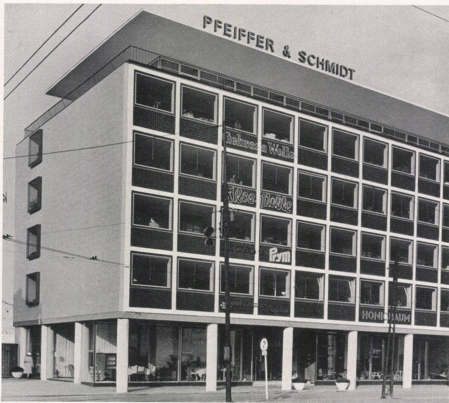
Südwestansicht. Vue du sud-ouest. View from the south-west.
