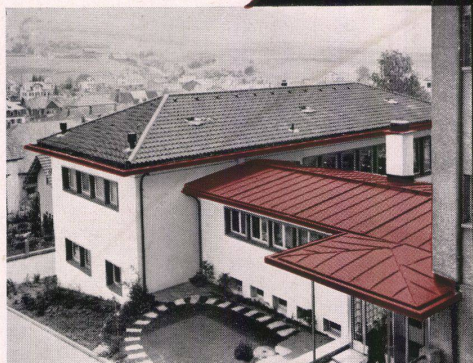
für sämtliche Spenglerarbeiten
