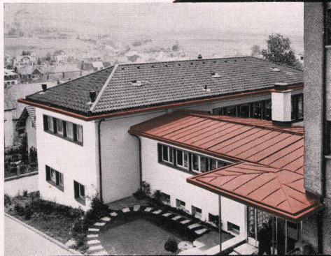
für sämtliche Spenglerarbeiten
