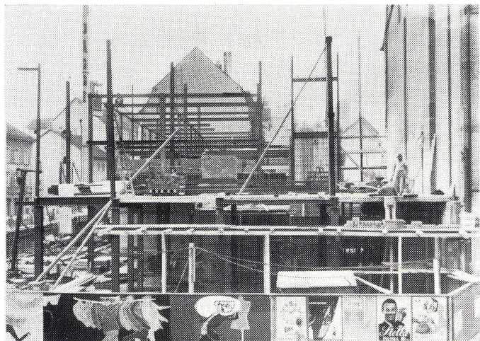
Stahlskelett zum Neubau Kleider-Frey Olten
