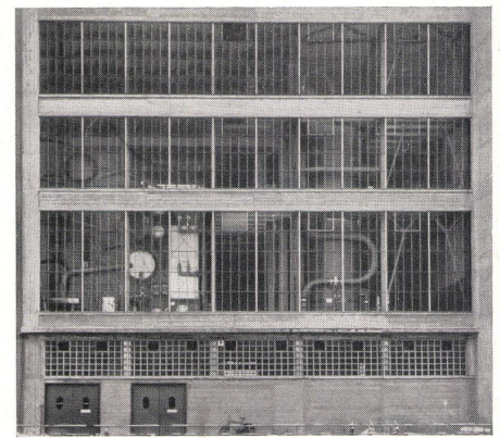
Energiezentrale, Westfassade. Kessel- und Regulierteil, Ausschnitt.
