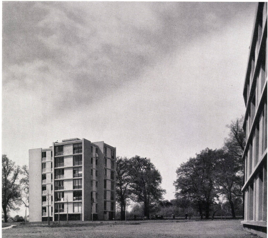
Nordostansicht des Wohnblocks Typ A im Parkgelände. Rechts Block B.
