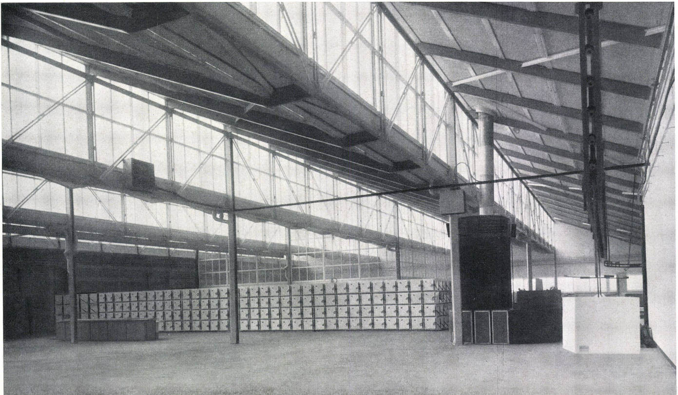
Fabrikhalle. Salle de fabrication. Factory hall.
