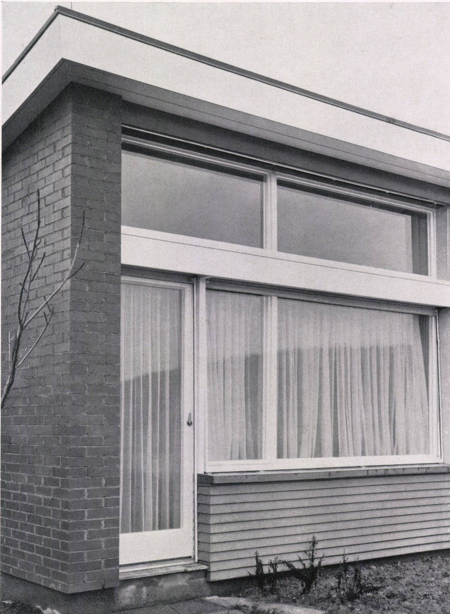
Fassadenteil des Elternschlafzimmers mit Rolladenkasten. Détail de la façade de la chambre à coucher des parents. Facade detail with parents' bedroom.
