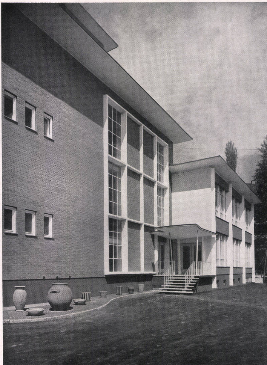
Blick gegen den Fabriкеingang und die rote Sichtmauer- werkfassade. Vue de l'entrée de la fabrique et de la façade en maçonnerie rouge visible. View towards factory entrance and the red rough brick- work elevation.
