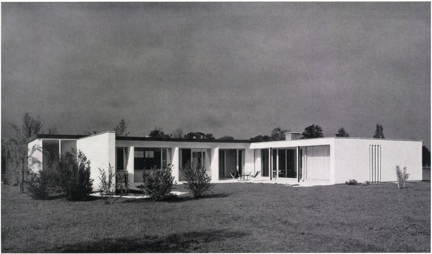
Ansicht vom Garten her (Südseite). Es folgen sich von links nach rechts: Geräteraum, Schlafzimmer, Arbeitszimmer, Diele und Wohnraum. Vue du côté sud, prise du jardin. The house from the garden.
