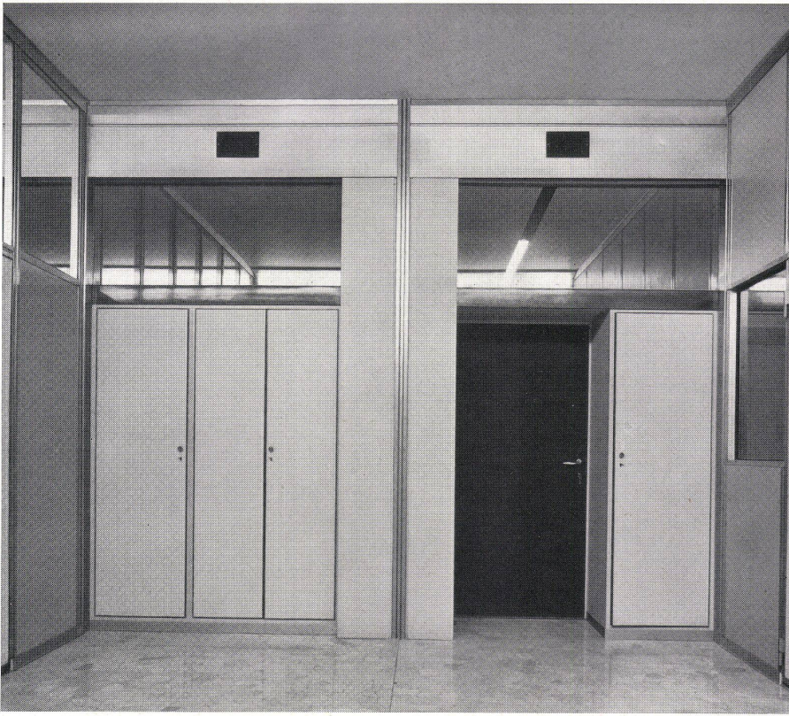
Details der Korridorwand eines Büros mit Zuluftöffnungen, Oberlichtstreifen und Profilschienen für Zwischenwände. Détails de la paroi du couloir d'un bureau. Detail of the corridor wall of an office.
