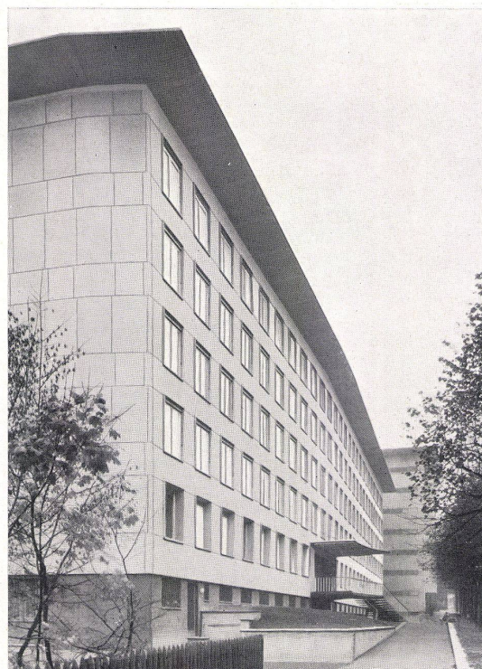
Eidgenössisches Verwaltungsgebäude Bern Fassadenverkleidungsplatten mit Fenster- einfassungen
