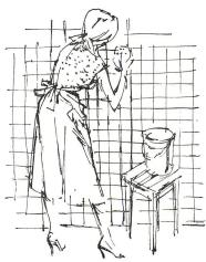
Balamur verlegt man so einfach wie eine Tapete. Es wird mit Balagum auf die Rohwand geklebt ... und hält! Da sich Balamur gut schneiden läßt, bereiten Aussparungen keine Schwierigkeiten.
