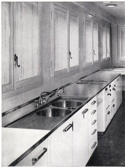
Fensterseite der Küche eines modernen Arzthauses am Bielersee; «Fresco»-Spar-Spültisch aus la rostfreiem Chromstahl mit ventilfreien runden Becken und separatem Ausguß, eingebautem Elektroherd und großen Abstellflächen aus la rostfreiem Chromstahl und Kunstharzplatten.
