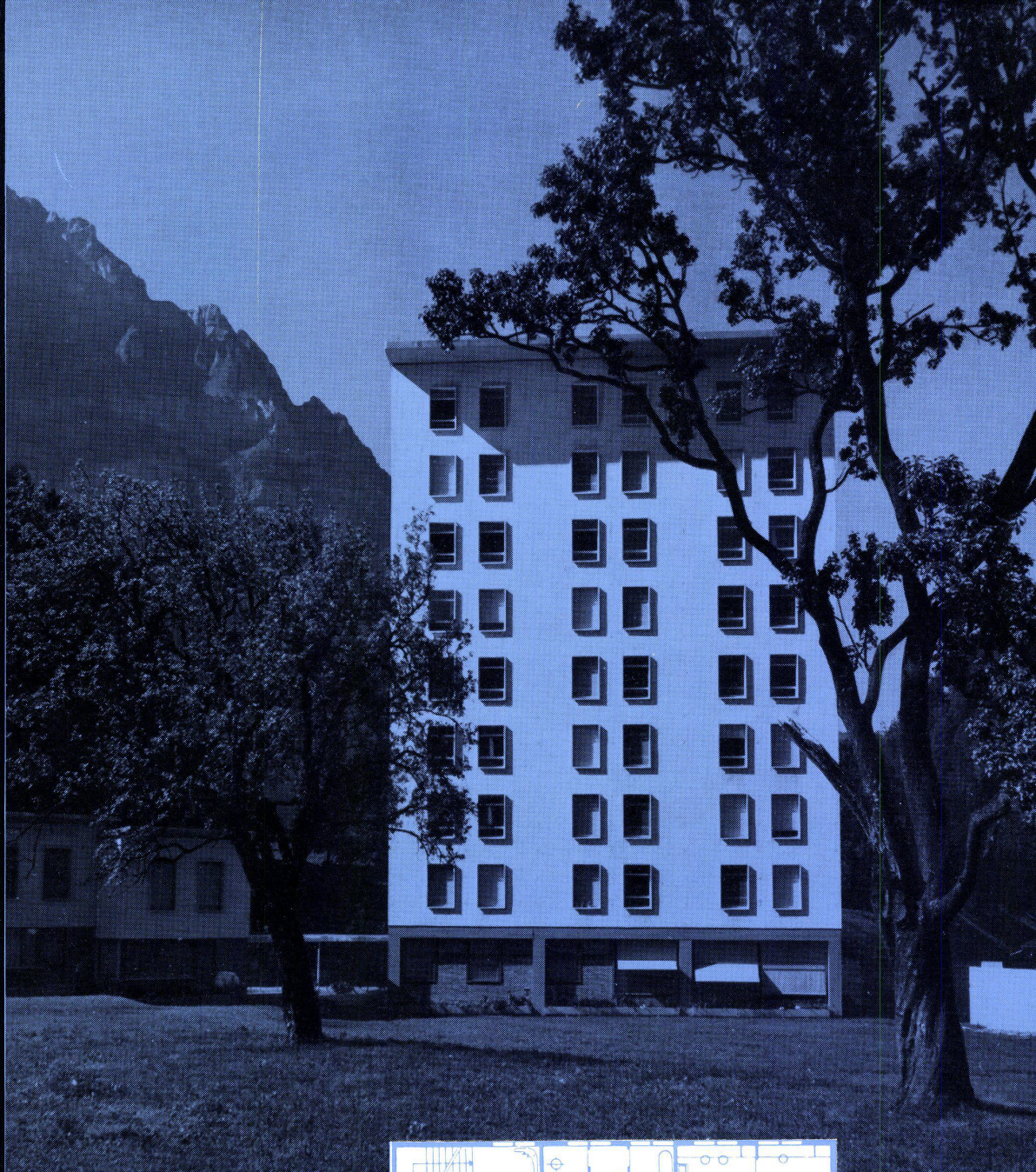
Schwestern- und Personalhaus zum Kantonsspital Glarus Architekt: Jakob Zweifel, SIA, Zürich / Glarus Ingenieur: Friedr. Pfeiffer, Zürich Außenwände aus 20 und 25 cm starkem Durisol-Mauerwerk
