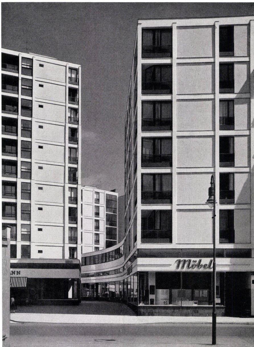
1 Hochhaus mit Seitenbauten, von Nordosten aus gesehen. Habitation-tour et annexes est vues du nord-est. Point-house with wings seen from north-east.
