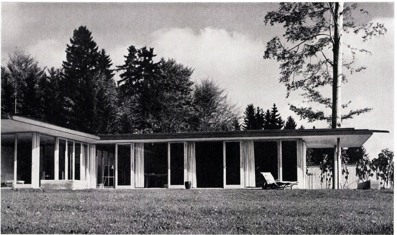
1 Schlaftrakt mit Freiterrasse, von Westen gesehen. Chambres à coucher avec terrasse ouverte vue de l'ouest. Bedroom area with terrace, view from west.
