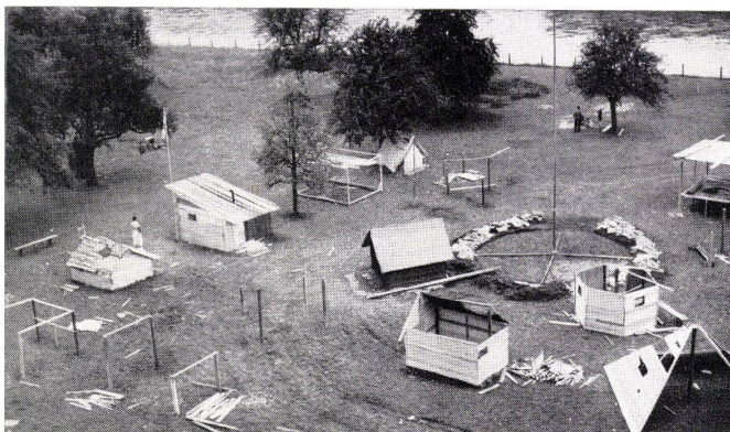
Hausbau auf dem Bau- und Werkspielplatz Wipkingen-Zürich.
