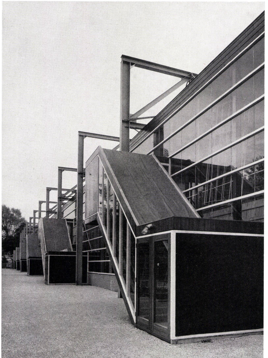
Ostseite der Sporthalle. Trennung von Konstruktion und Raumabschluß. Gedeckte Tribünenaufgänge. Côté est de la salle des sports. Séparation de la construc- tion et de la paroi. Accès couverts à la tribune. East side of sport hall. Separation of construction and outside wall. Covered accesses to galleries.
