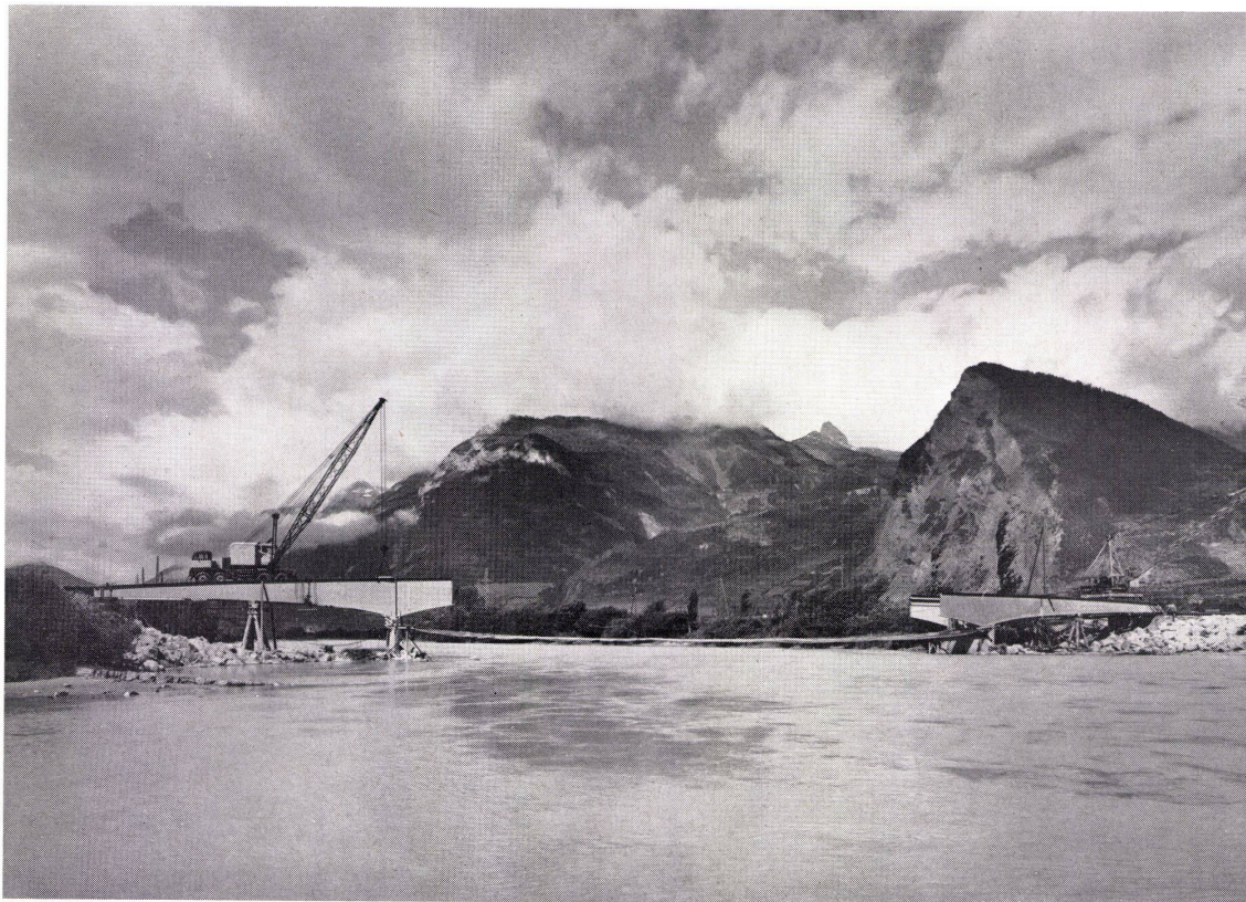
Pont sur le Rhône soudé Ac. 60-T.
